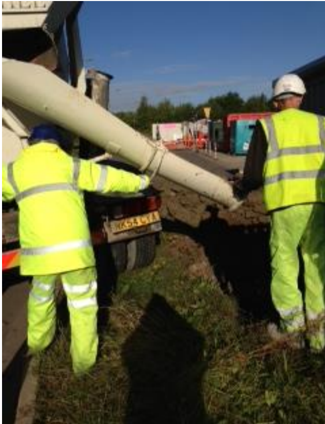
Figures 4.36 Process of Concrete Pour
